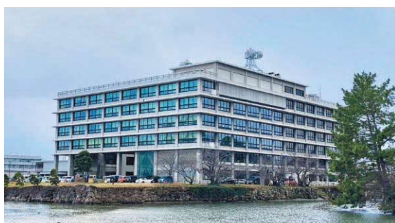
三之丸の石垣と島根県庁舎本庁舎
