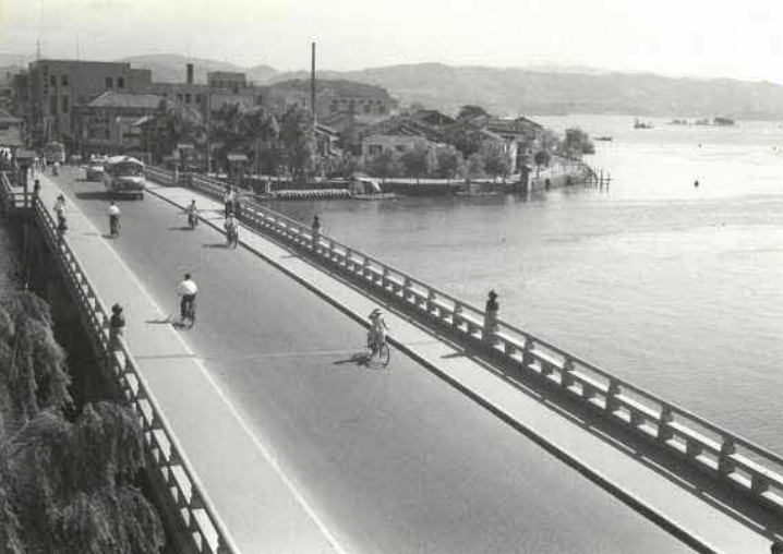
17代松江大橋 昭和12年(1937)竣工
