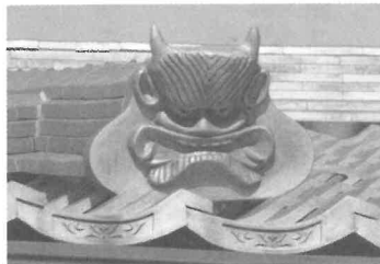
出土瓦を復元し屋根に葺く
